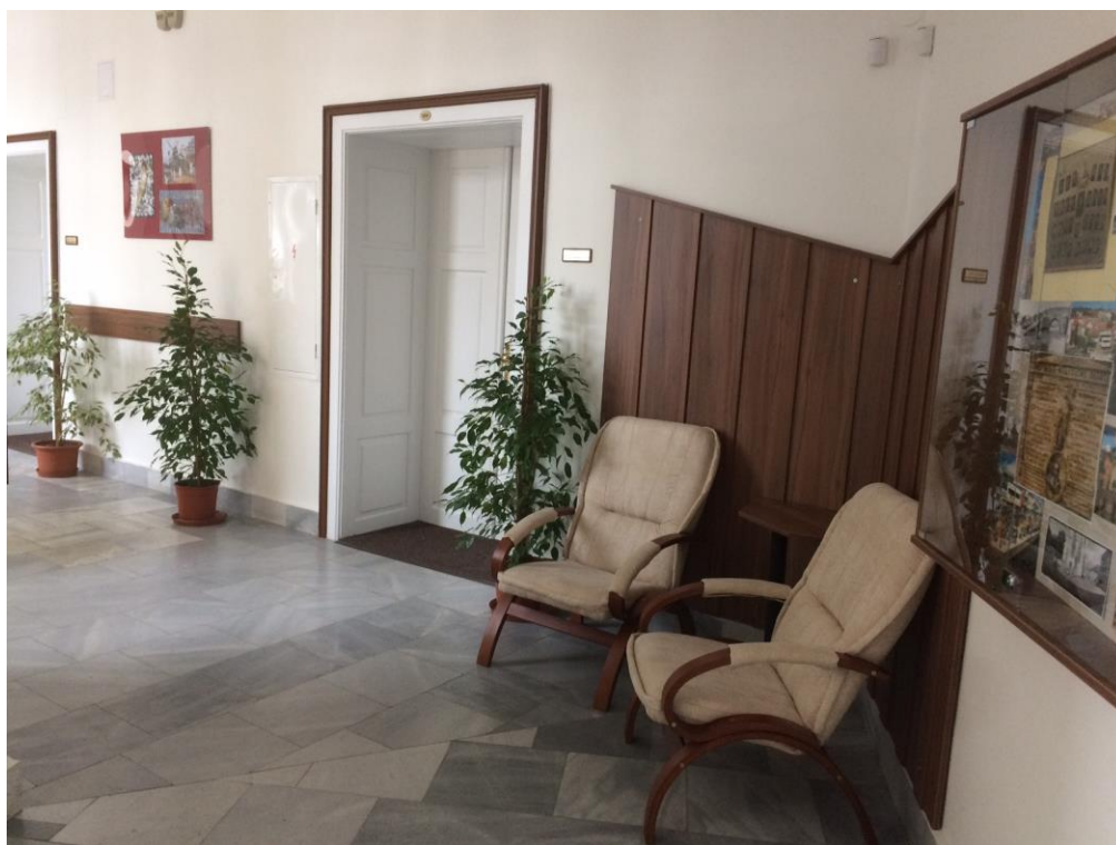
Zrekonstruovaná chodba v budově A
